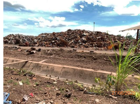
ภาพที่ 2.2-16 รางระบายน้ำฝนบริเวณพื้นที่ ลานกองเศษเหล็ก
