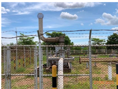
ภาพที่ 2.2-36 Pressure Relief Valve บริเวณ Gas Station
