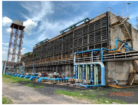
ภาพที่ 2.2-14 ระบบปรับปรุงคุณภาพน้ำจากหอหล่อเย็น
