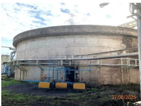
ระบบรวมตะกอนและตกตะกอน
