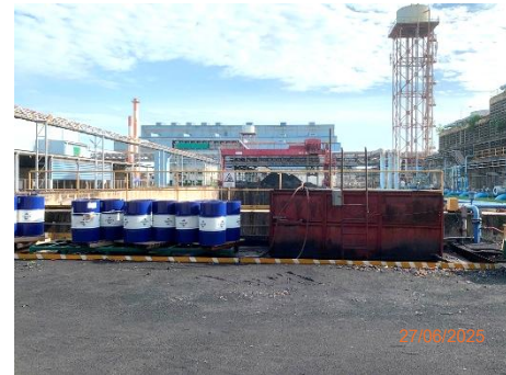
ภาพที่ 2.2-12 ระบบดักและแยกคราบน้ำมัน
