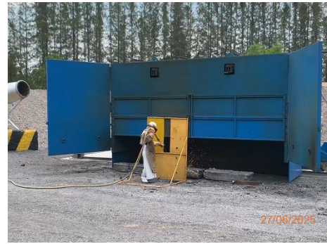
ภาพที่ 2.2-2 อุปกรณ์ป้องกันฝุ่นและ ควันที่เกิดจากการตัดเหล็กก้อน
