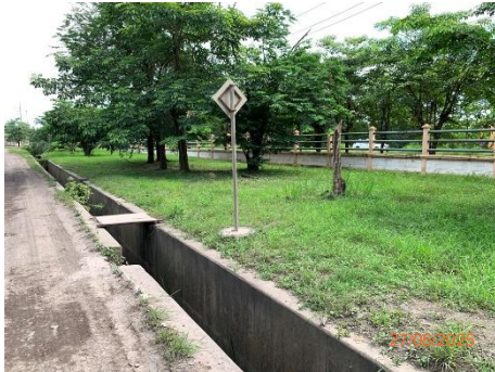
ภาพที่ 2.2-15 รางระบายน้ำฝนขนานไปกับ แนวรั้วรอบพื้นที่โรงงาน
