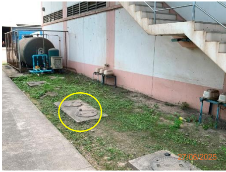
ภาพที่ 2.2-9 ถังบำบัดน้ำเสียสำเร็จรูป บริเวณอาคารสำนักงาน
