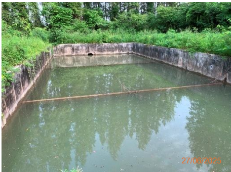
ภาพที่ 2.2-17 บ่อตกตะกอนที่รองรับน้ำฝน บริเวณพื้นที่ลานกองเศษเหล็ก
